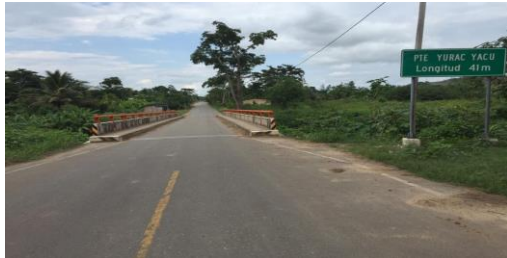
EN ESTA VISTA TAMBIEN SE APRECIA EL PUNETE SOBRE LA QUEBRADA YURACYACU QUE COMO SE INDICA PODRIA SER AFECTADO EN SU ESTRUCTURA POR LAS FUERTES CRECIDAS DE LA MISMA
