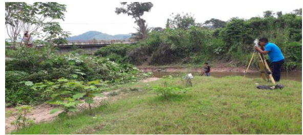
EN LA PRESENTE SE APRECIA EL LEVANTAMIENTO TOPOGRAFICO EN AMBAS MARGENES DE LA QUEBRADA EROSIONADAS POR LAS CRECIDAS DE LA CORRIENTE DEL RIO (QUEBRADA) YURACYACU QUE SON LAS ZONAS A PROTEGER
